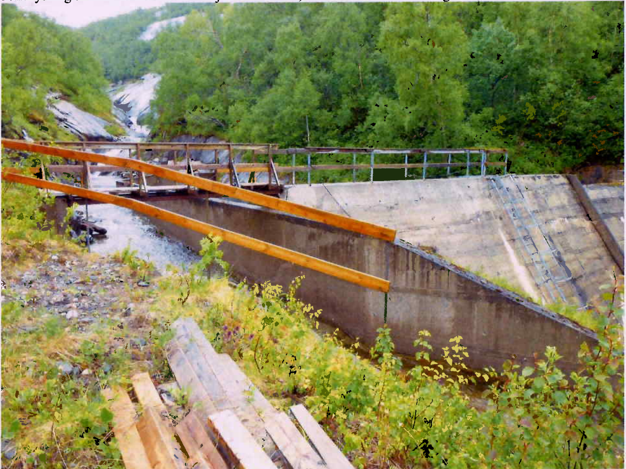
Bilde 1 viser massivdam med tilførsel fra Ågleiåga i bakgrunnen.
