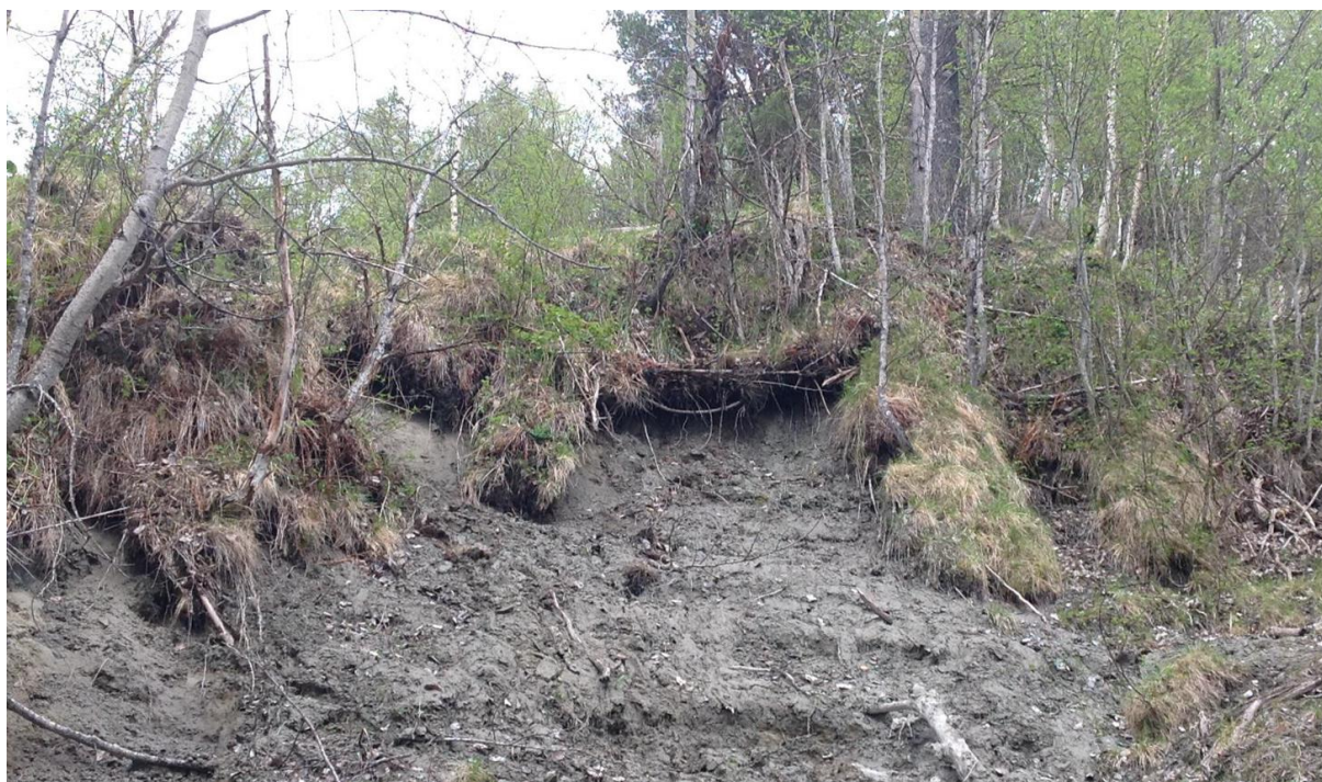
Figur 5.12 Bilde S35: Grunnvannserosjon i skråning. Sand over et lag med finkornet materiale. Finkornede masser renner nedover skråningen
