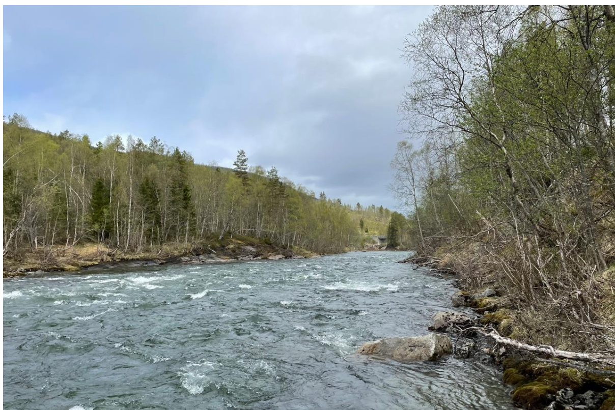
Figur 5.15 Bilde J316. Berg i dagen på motsatt side av Beiarelva. Elveløp erosjonssikret med blokker
